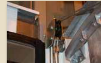
2 câbles type aviation 7 torons par côté
